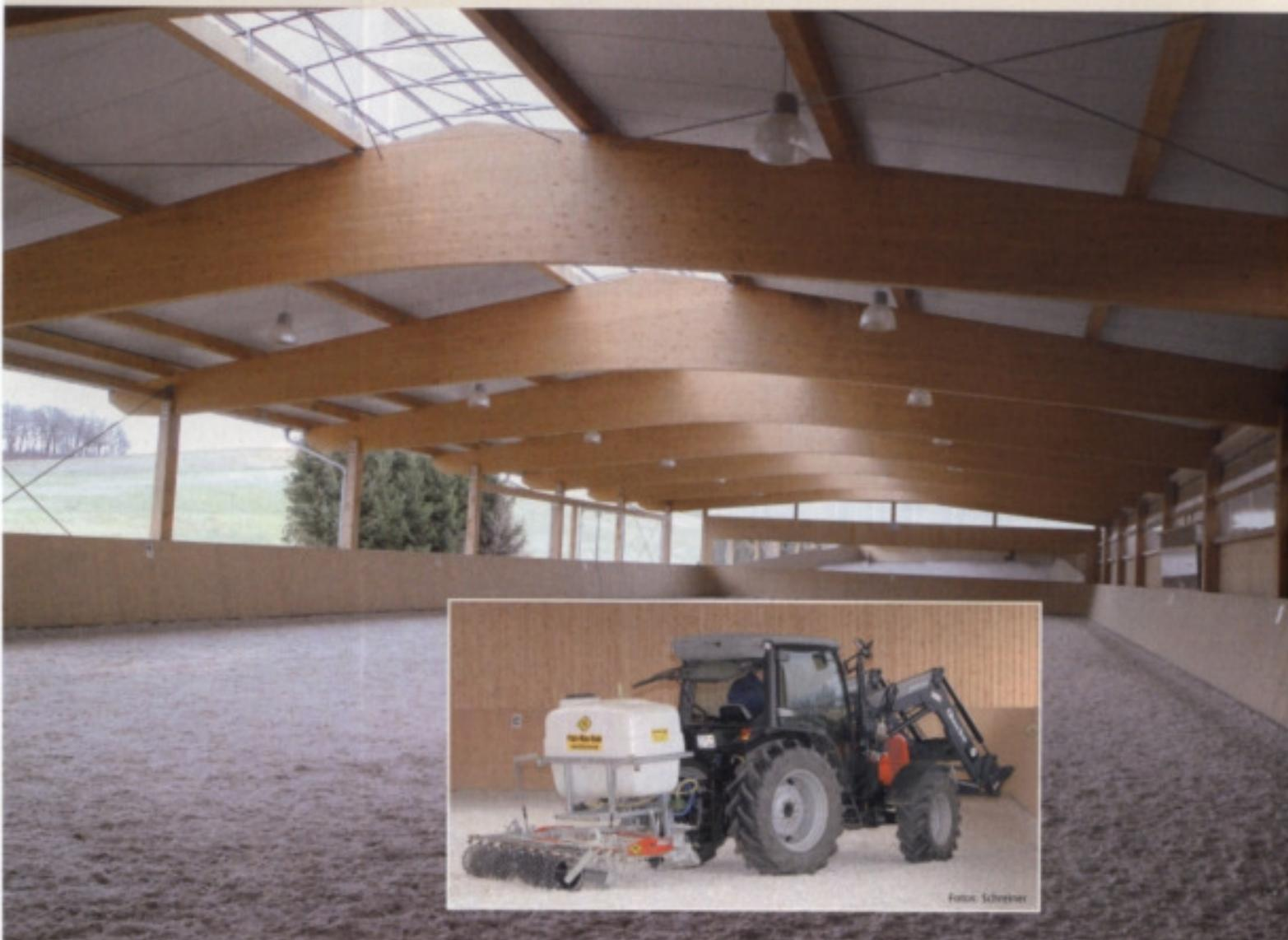
Die Reithalle (20 x 60) besitzt einen Lichtfirst. Die offene Seite sorgt für viel frische Luft. In der kalten Jahreszeit halten installierte Windschutznetze die Witterung draußen. Die Tretschicht wird regelmäßig bearbeitet und direkt gewässert.
